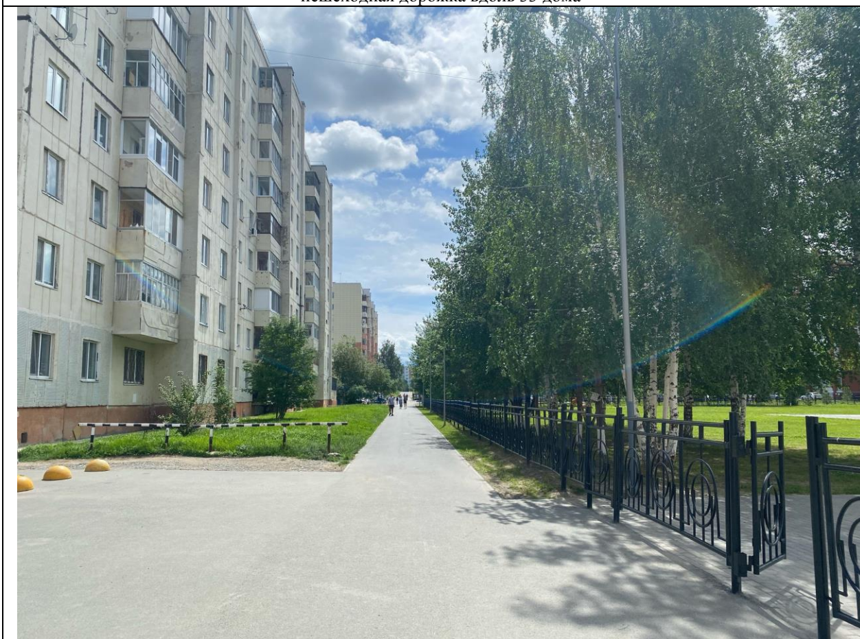
пешеходная дорожка вдоль 30 домf
